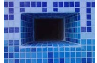
Pegado y sellado entre elementos de piscinas
